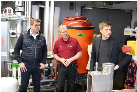
Stefan Opel (Meisterschule Installateure und Heizungsbau) erläuterte die Funktionsweise der Sole-Wasser-Wärmepumpe.
